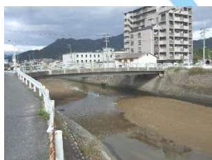
経免大橋 L=25.6m(PC橋) 1986年架設
