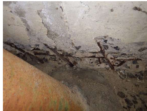
コンクリート床版の剥離、鉄筋露出 (修繕済)
