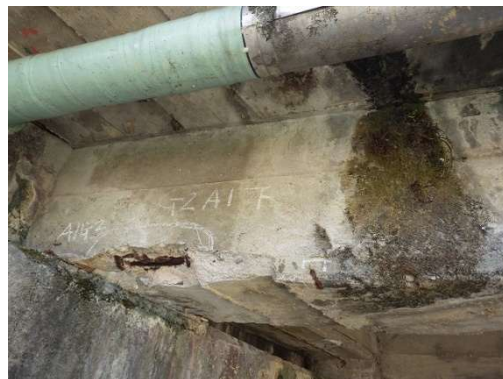
コンクリートのはく離・鉄筋露出
