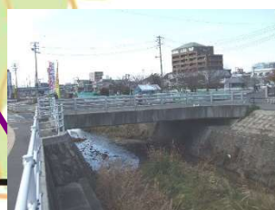
経免橋 L=14.5m(PC橋) 2001年架設
