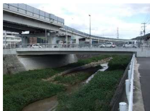
平成鶴江橋 L=27.2m(PC橋) 2008年架設
