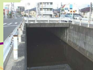
入川橋 L=7.8m(RC橋) 1970年架設
