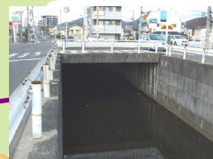
入川橋 L=7.8m(RC橋) 1970年架設
