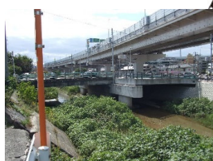
新石井尻橋 L=29.0m(PC橋) 1973年架設
