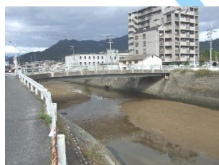
経免大橋 L=25.6m(PC橋) 1986年架設
