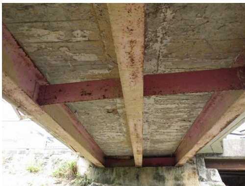
主桁の腐食・防食機能の劣化 (修繕済)
