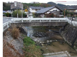
山田大橋 L=12.7m(PC橋) 1973年架設
