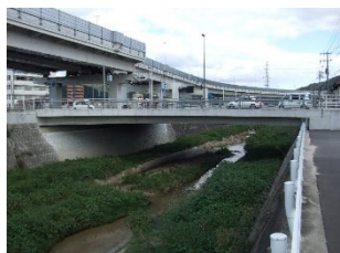
平成鶴江橋 L=27.2m(PC橋) 2008年架設
