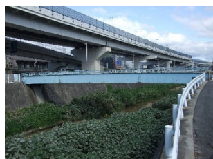
下鶴江橋 L=25.2m(鋼橋) 1986年架設
