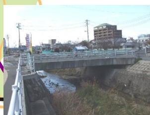
経免橋 L=14.5m(PC橋) 2001年架設
