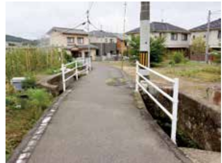
写真 28 水路と道路の現況
