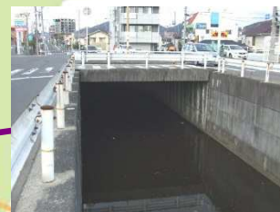
入川橋 L=7.8m(RC橋) 1970年架設
