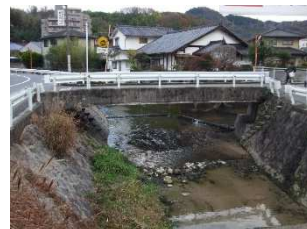
山田大橋 L=12.7m(PC橋) 1973年架設
