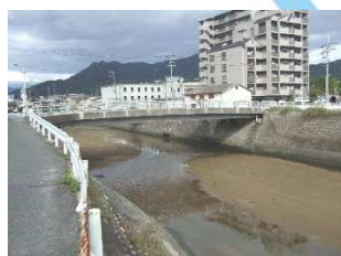
経免大橋 L=25.6m(PC橋) 1986年架設
