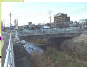
経免橋 L=14.5m(PC橋) 2001年架設
