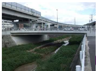
平成鶴江橋 L=27.2m(PC橋) 2008年架設
