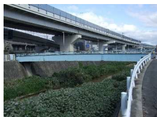
下鶴江橋 L=25.2m(鋼橋) 1986年架設
