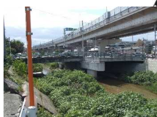
新石井尻橋 L=29.0m(PC橋) 1973年架設
