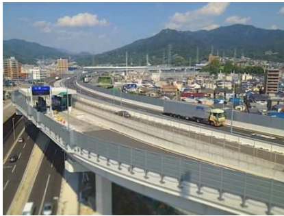
▲広島高速道路(県道)府中仁保道路
