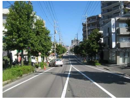
▲町内シンボル道路(町道)鶴江鹿籠線
