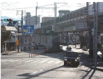
▲広域幹線道路(県道)土橋船越線
