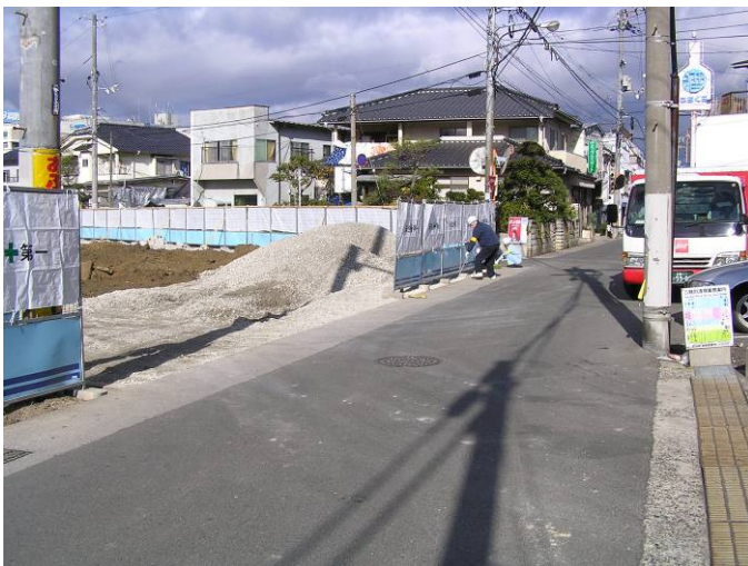
(平成 17 年 11 月向洋駅北口付近で撮影)
