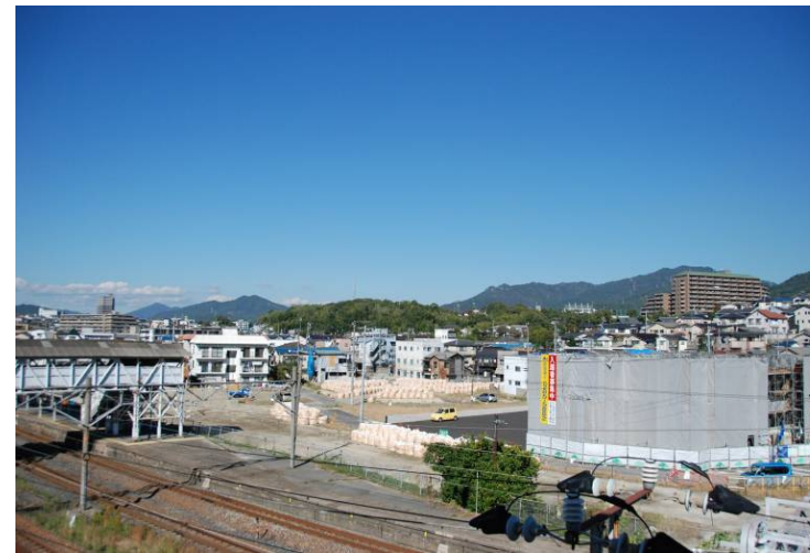
平成22年11月向洋駅北口撮影
