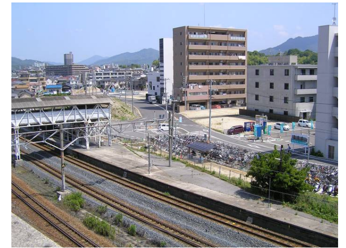
平成25年6月向洋駅北口撮影
