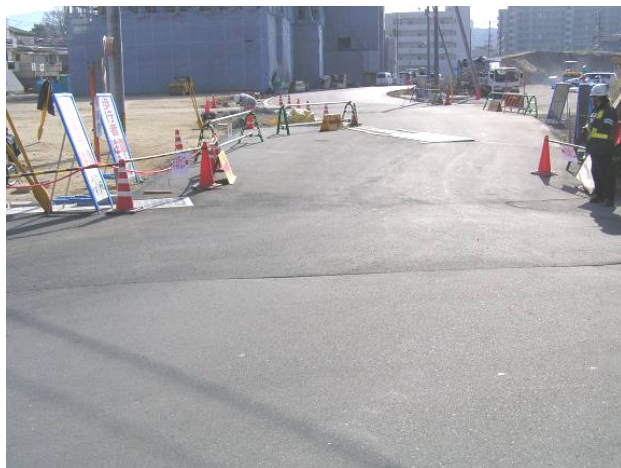
向洋駅北口に向かって撮影 (平成 25 年 1 月 8 日現在)
