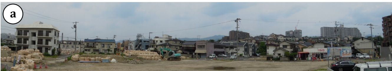
平成23年度工事予定箇所 向洋駅北口簡易改札付近
