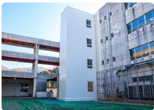
エレベーター(府中東小学校)
