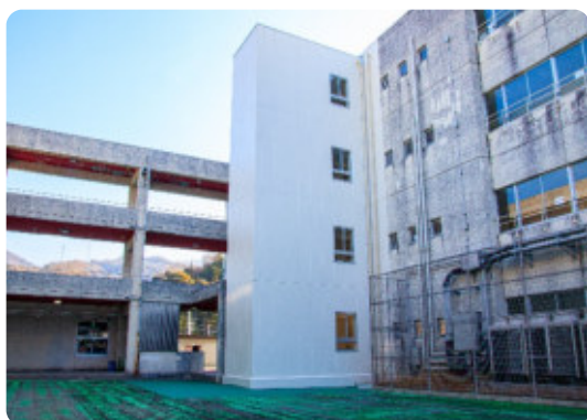
新設されたエレベーター(府中東小学校)
