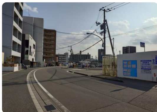
向洋駅北口付近の様子(令和8年1月)
