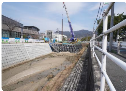
榎川(河川改修の様子)
