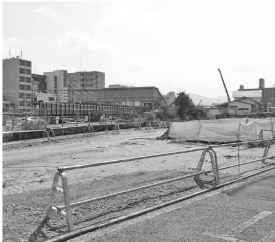
街区の整備が進むJR向洋駅南側（青崎南）
