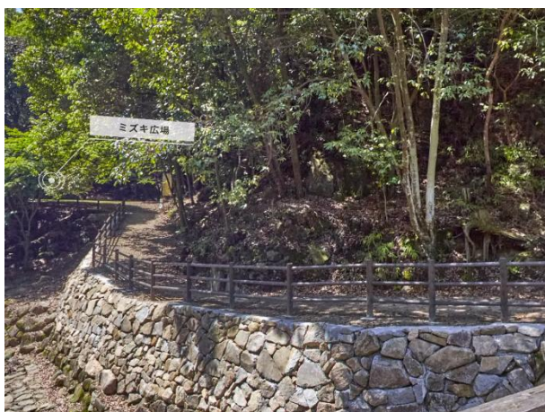
みずき広場（スロープ、転落防止柵）
