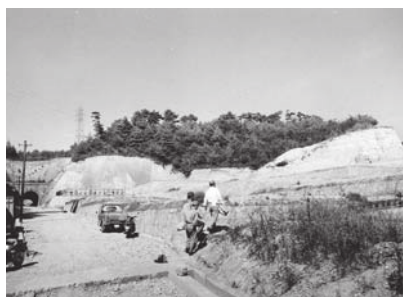
造成中の柳ヶ丘団地 南部新池（現鷗崎公園）から府中隧道方向を望む
