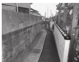
城ヶ丘団地内の暗渠
