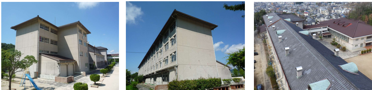
校舎 現況写真
