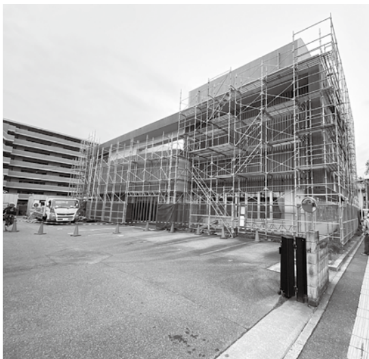
改修工事が進む、マイ・フローラ南交流センター
