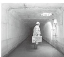
主要道路下の雨水管は2月にも点検を実施済
