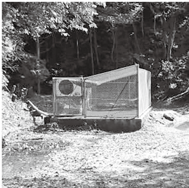
未舗装部分が残る、花立山防火水槽
