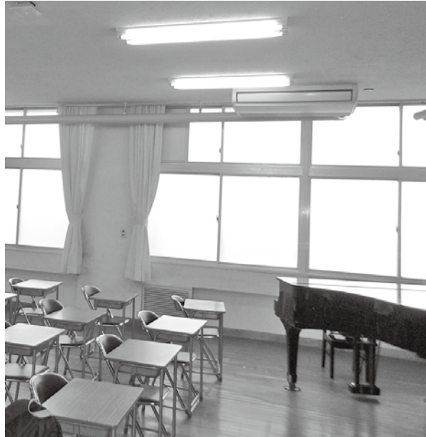
新たにエアコンが設置された南小学校音楽室
