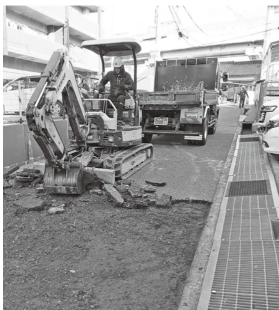
古くなった舗装を撤去する様子
