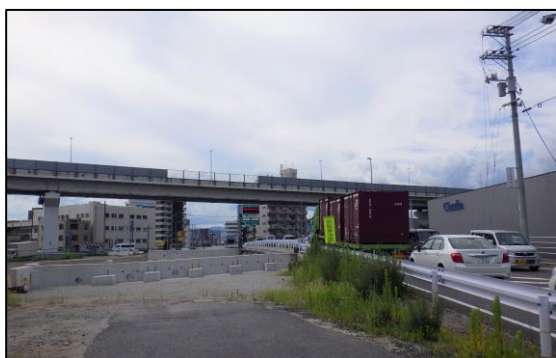
写真1 新大洲橋工事状況
