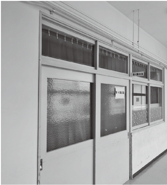
暗幕を設置して收藏品を保管（府中小学校東棟）
