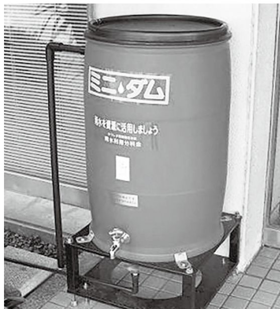
雨水貯留施設の設置例（埼玉県戸田市）
