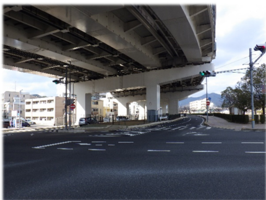
広島高速 2 号線高架下
