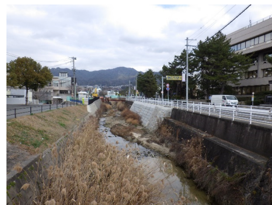
榎川河川改修事業
