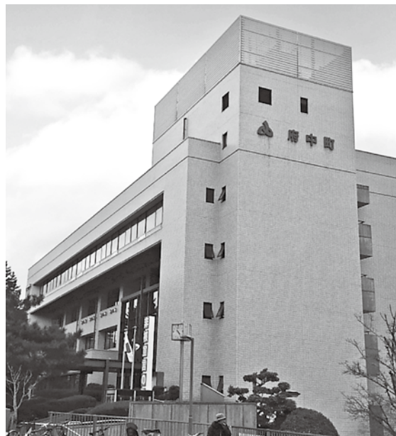
1984年に建てられた役場庁舎
