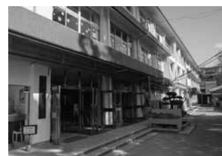
小学校施設改修等事業 南小学校校舎の外壁改修な どを実施
