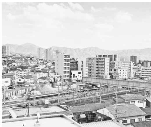
仮線工事や街区整備工事が着々と進む
