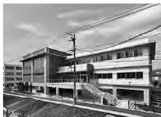
府中公民館等改築事業 府中公民館等複合施設の改築 工事を実施
