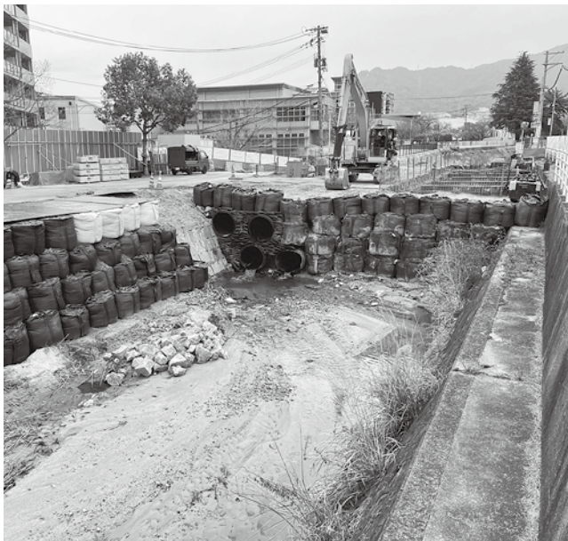
復旧工事が進む榎川護岸
