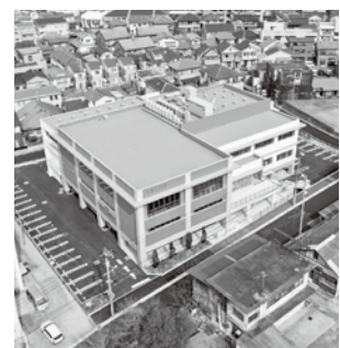
上空から見た府中公民館・府中町歴史民俗資料館の全景
