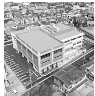
上空から見た府中公民館・府中町歴史民俗資料館の全景
