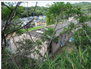
山田ブロック住宅
