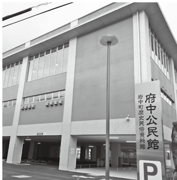
完成間近の府中公民館
