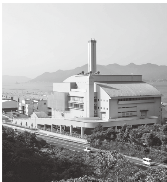
ごみ等を処理する安芸クリーンセンター
