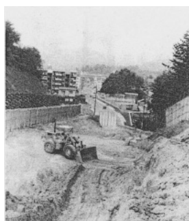
写真③隧道の取り壊し工事
