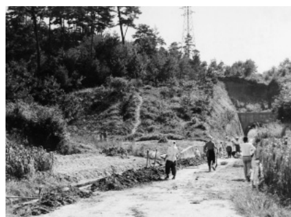
写真②隧道付近（北口から）
