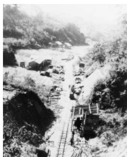
写真③④工事風景（鹿籠側から撮影）
