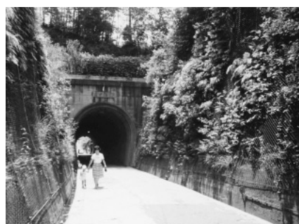
写真②隧道（北口）昭和59年撮影
