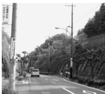
写真①隧道があった場所（浜田2丁目付近）
