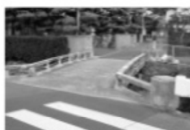
写真② 新宮橋
