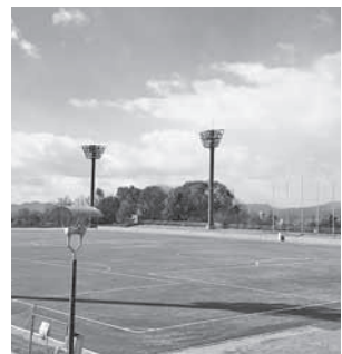
青空の下、緑が映える新しい人 工芝グラウンドを撮影しました。 (工事施工中に、現場事務所から撮影)
