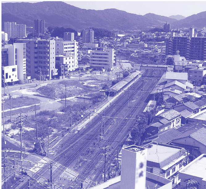
早期着工が望まれる連続立体交差事業
