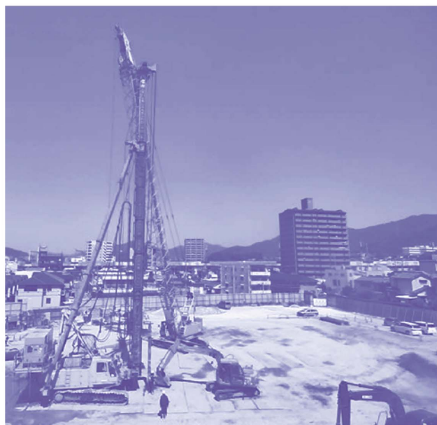
建設が進む府中中央小学校
