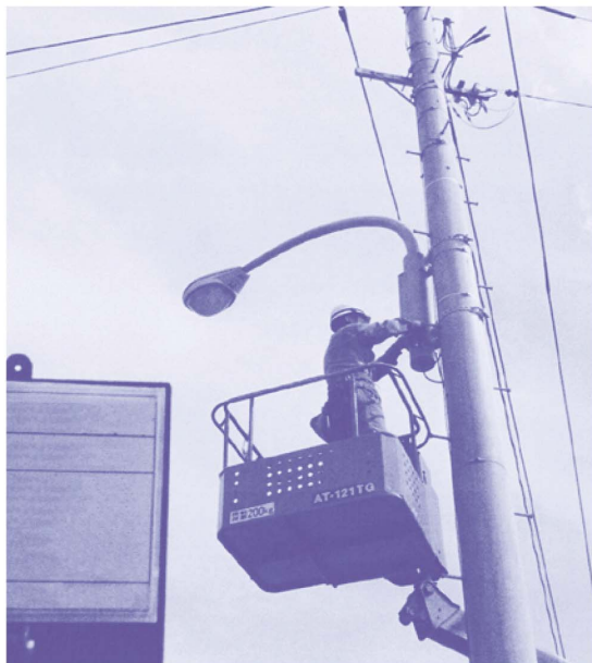
道路灯の補修・点検
