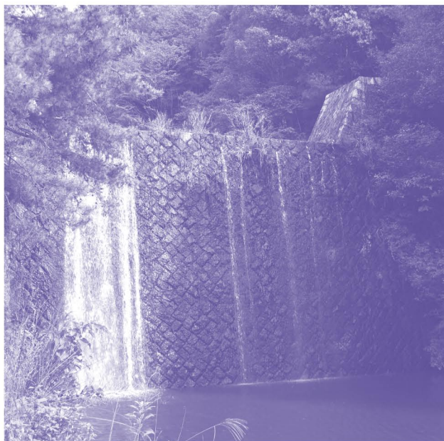
御衣尾川砂防ダム
