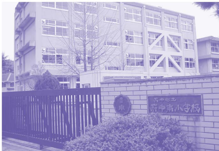
第Ⅰ期工事の耐震補強を終えた南小管理教室棟
