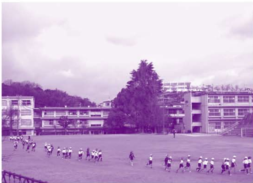
耐震化を行う府中南小学校
