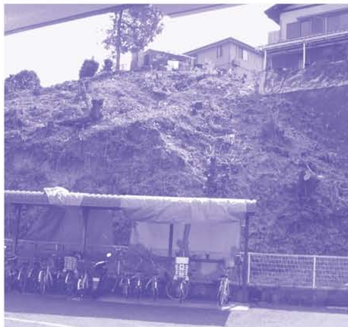
今年度改修予定の急傾斜地
