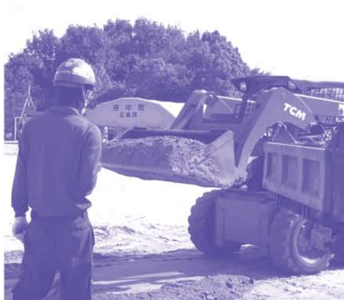
平成23年度総合防災訓練に参加する建設業者
