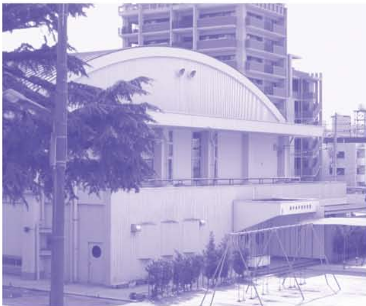
改修予定の府中小学校体育館
