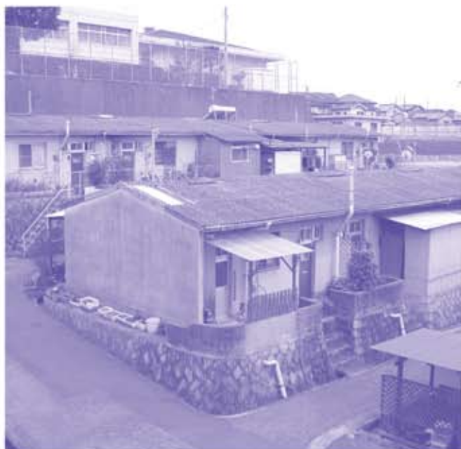
老朽化している山田町営住宅
