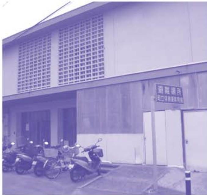
旧中学校の体育館で、老朽化が進む町立体育場
