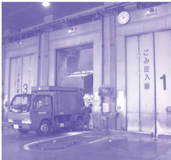
安芸クリーンセンターのプラットフォーム
