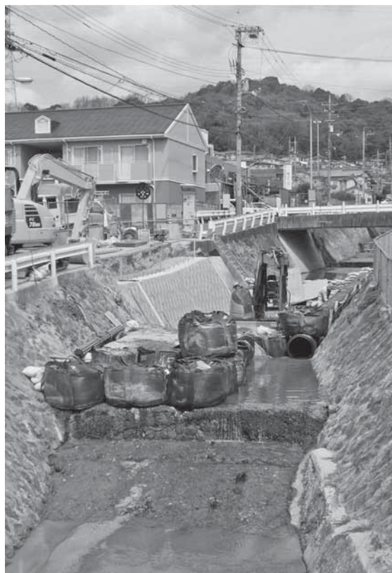
町道・榎川護岸復旧工事
