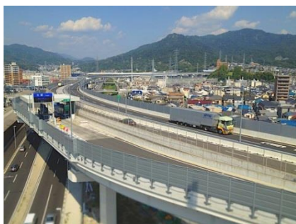
▲広島高速道路(県道)府中仁保道路
