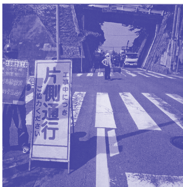
工事中の安全管理
