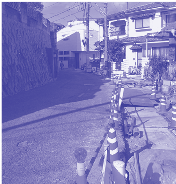
補助街路の整備（町道青崎25号線）
