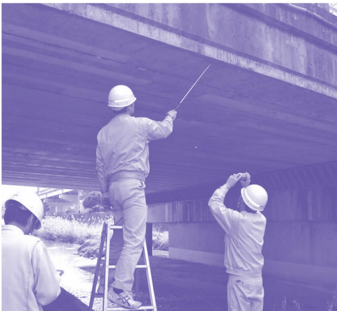
橋りょう点検
